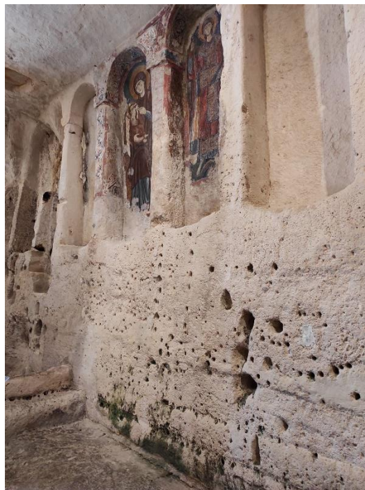
Cerkvica izklesana v skalo, na spodnjem delu zidu se lepo vidijo plasti, ko so poglobili cerkev
