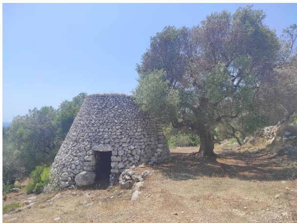
Značilno zidano zavetišče v oljčniku
